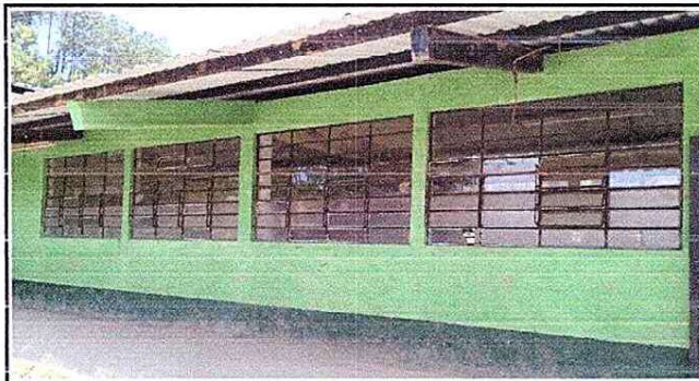
FOTO 3: INSTALACIÓN DE BALCONES
