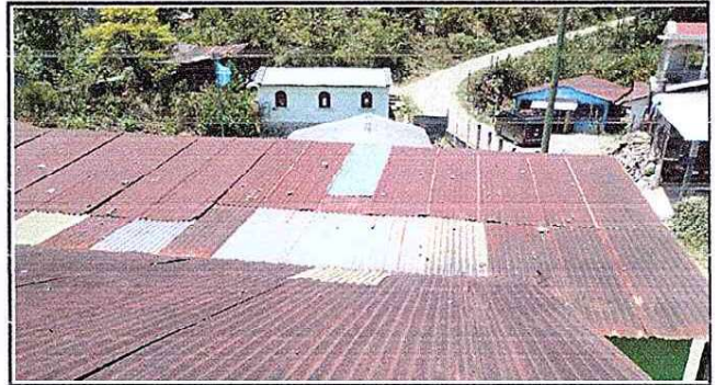
FOTO 2: SUSTITUCIÓN DE TECHO Y ESTRUCTURA DE MADERA POR LAMINA TROQUELADA Y ESTRUCTURA DE METAL
